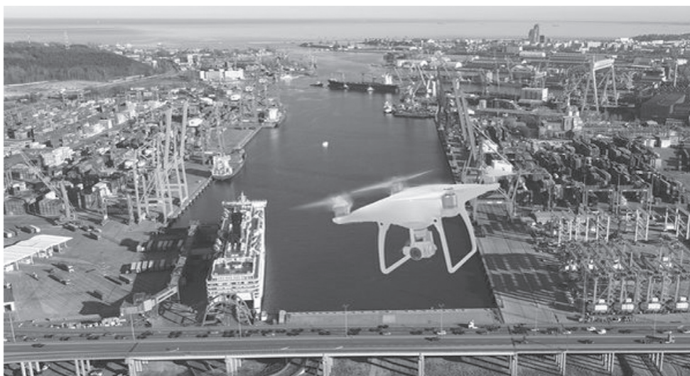
Fot. 3. Port Gdynia
